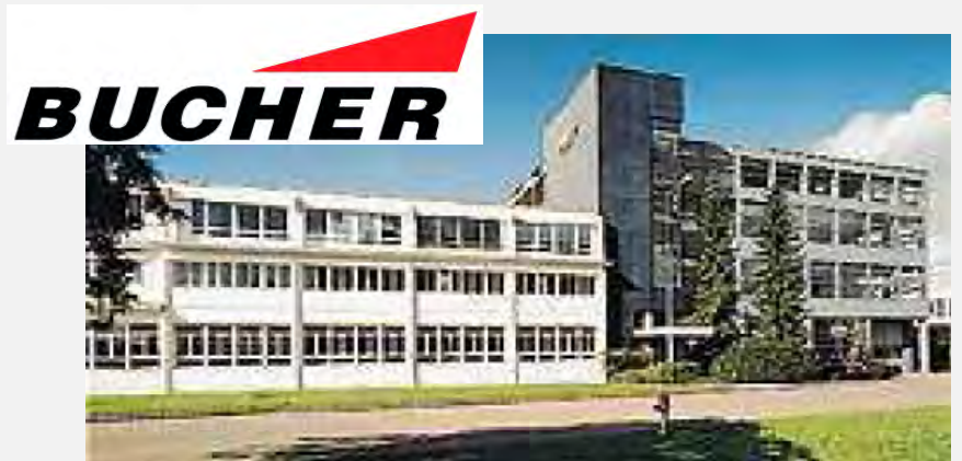
Der Firmensitz der Bucher Leichtbau AG in Fällanden in der Schweiz
