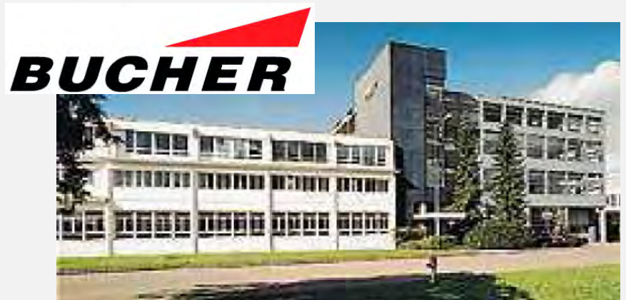
The Bucher Leichtbau headquarters in Fällanden, Switzerland
