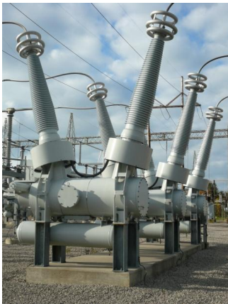
"Serbatoio morto" interruttore di circuito con isolatori in ceramica CERALEP
