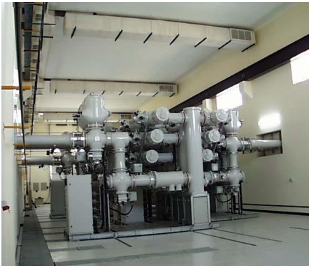
Eine gasisolierte Schaltanlage, die von Siemens T&D nach Schardscha in den Vereinigten Arabischen Emiraten geliefert wurde
