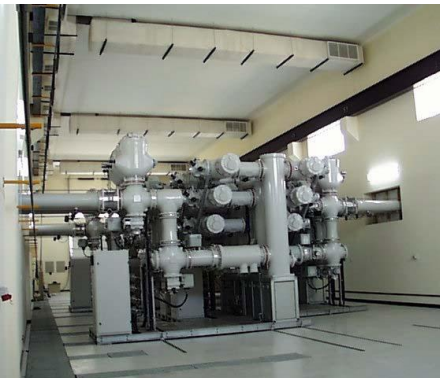
Una sottostazione isolata in gas (GIS) fornita da Siemens T&D a Sharjah negli Emirati Arabi Uniti
