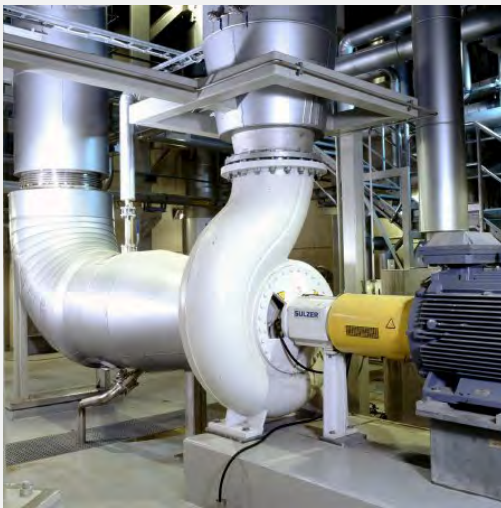
Pompe de circulation AHLSTAR™ APP pompe la liqueur noire venant de la compression de pulp végétale. A droite la coupe d'une pompe similaire
